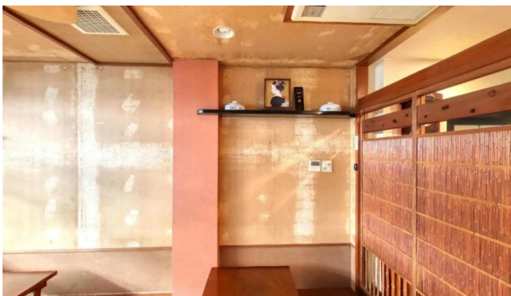
古扇楼 半田市
